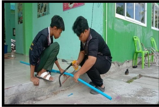
ภาพที่ 3.20 ตัดท่อ PVC ตามขนาดที่ต้องการ
